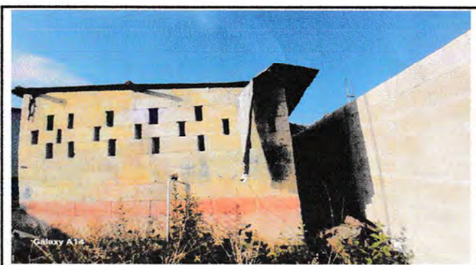
Foto 3: Exterior de cocina
