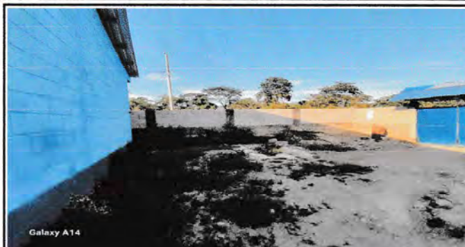
Foto 2: Losa de Patio
